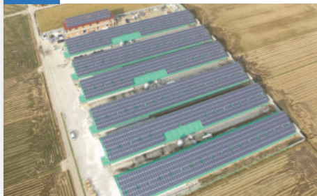
999kW 전북 익산시 만석동 644-2번지 (종계)
