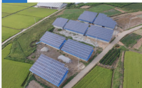
300kW 전북 부안군 보안면 신복리 357번지 (버섯)
